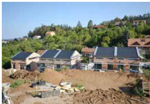
Celkový pohled – stav ke dni 6. září 2018
