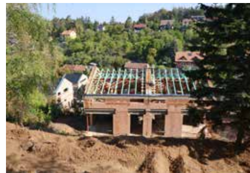
Celkový pohled – stav ke dni 6. září 2018
