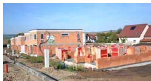
Novostavby RD 4+kk – stav ke dni 10. září 2019
