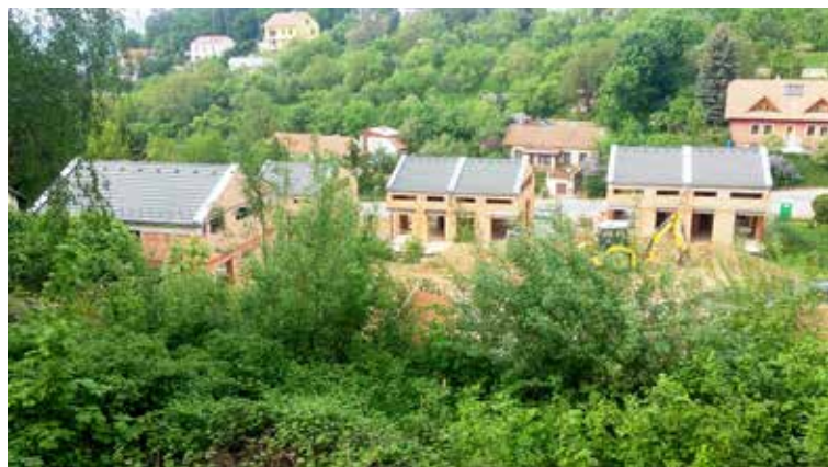
Celkový pohled – stav ke dni 3. května 2018
